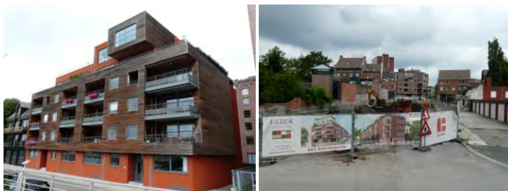
Figuur 11, 12 appartementsbouw in het centrum van Boom
